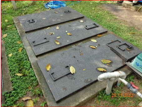
ภาพที่ 2-10 บ่อตรวจสอบ (Inspection Pit)
