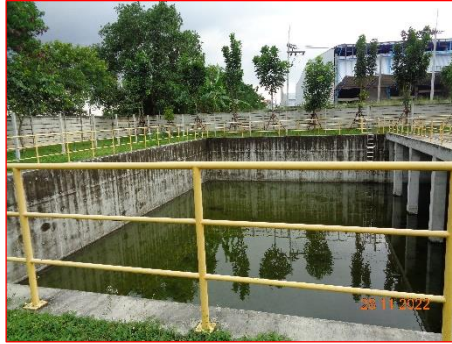
ภาพที่ 2-30 บ่อหน่วงน้ำฝนของโครงการ
